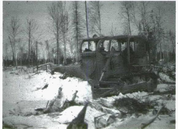
*Préparation du site pour la plantation ou l'ensemencement, au moyen d'un bulldozer muni d'une grappe aiguisée. Le travail est effectué en hiver afin de minimiser les perturbations de la station.*
